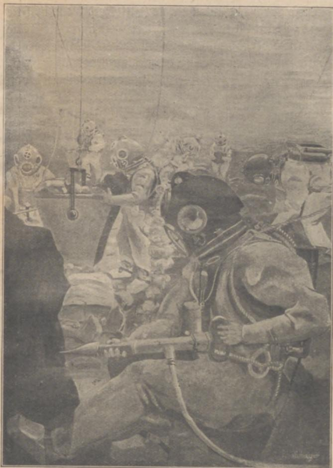
Abb. 7. Tauchergruppe mit schlauchlosen Träger-Tauchgeräten,
