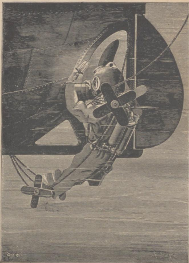
Schiffsbodenuntersuchung. Taucher im Schlippnetz.
