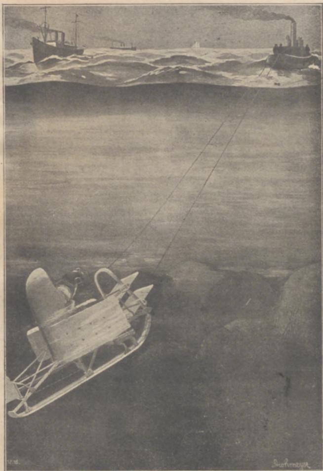
Abb. 17. Unterseeschlitten für Träger-Taucher in Betrieb.
