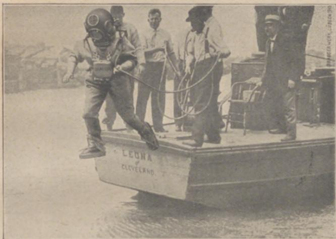
Taucherabstieg mit schlauchlosem, frei tragbarem Dräger-Tauchergerät.
