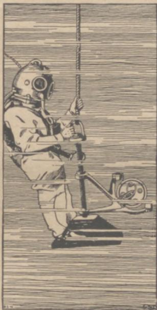
Abb. 11. Taucher im Aufstieg auf der Grundrolle stehend.
