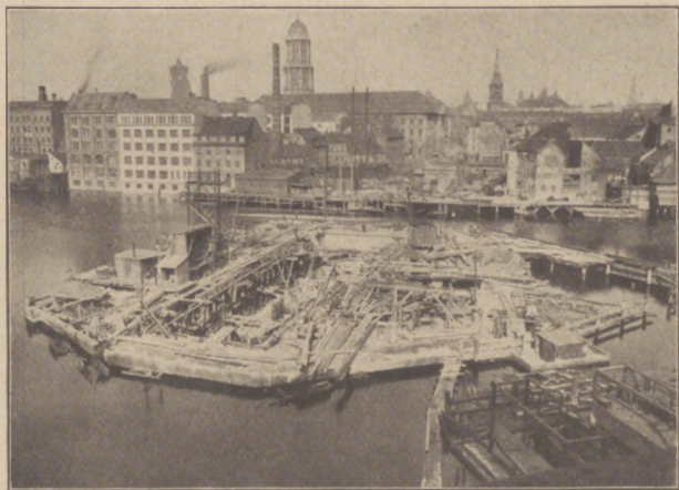
Dritter Bauabschnitt des Spreetunnels.
