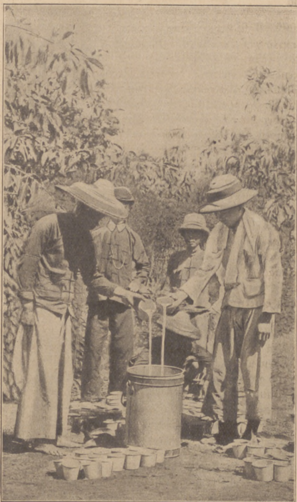
Die Kautschukmilch wird durch ein Sieb gegossen. F. D. Koch.
