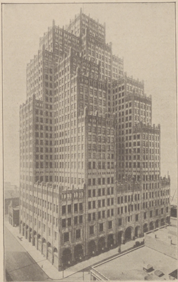
Das „Mammothhaus“ der South-Western Bell-Telephone Company in Saint Louis. Die oberste Plattform befindet sich zwei- unddreißig Stock über dem Boden. Scherl.
