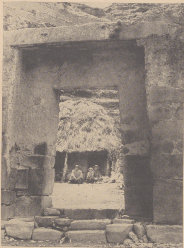
Eines der typischen trapezförmigen Tore aus der Inkazeit. Bei allen Bauwerken aus der vorkolumbianischen Zeit findet sich diese Form bei den Götternischen und Hauseingängen.
