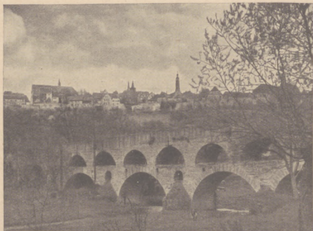
Tauberbrücke bei Rothenburg
