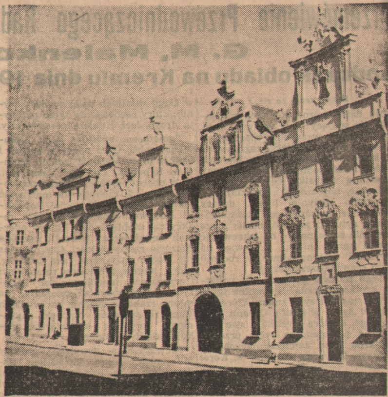
W Opolu przeprowadza się obecnie odbudowę zabytkowych kamieniczek otaczających Rynek. Całkowicie ukończono już odbudowę strony południowej.
