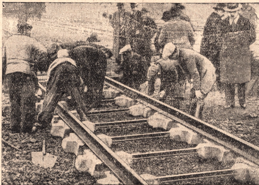
PRÓBY Z NOWYMI PODKŁADAMI KOLEJOWYMI.
