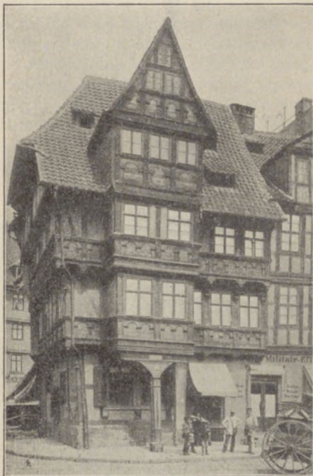
Holzhaus in Halberstadt.
