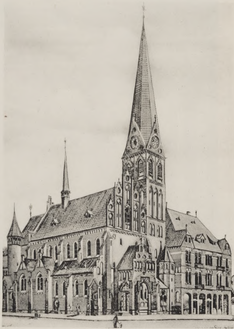
St. Albani Kirche (Grundsteinlegung 21.—10. 1906).
