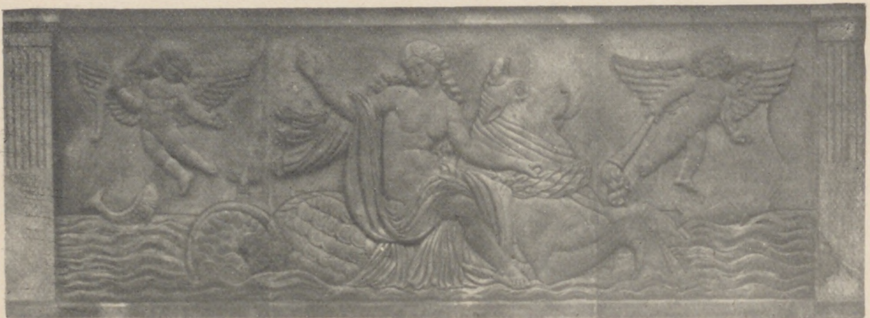
Abb. 118. Georg Römer: Relief an der Außenseite der Kunsthalle in Bremen. (Zu Seite 78.)
