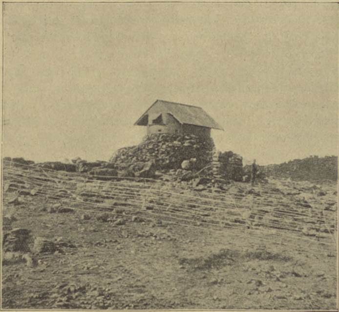
Lord Kiteneers Blochhausystem. Fertige Blochhäuser. (Im Vordergrund die Stacheldrahtzäune.)
