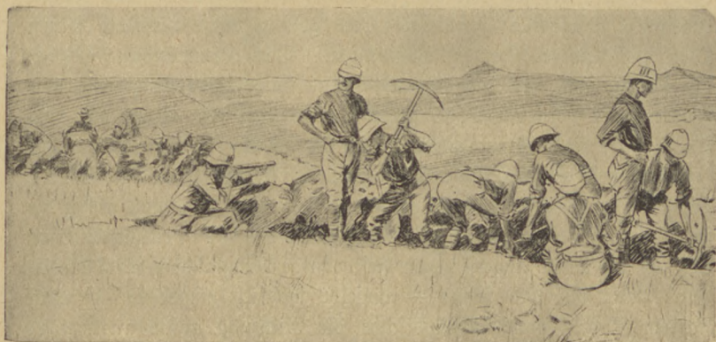
Englische Soldaten werfen Schanzen auf zum Schutze der bedrohten Bahnlinsen. (Nach der Skizze eines englischen Offiziers)
