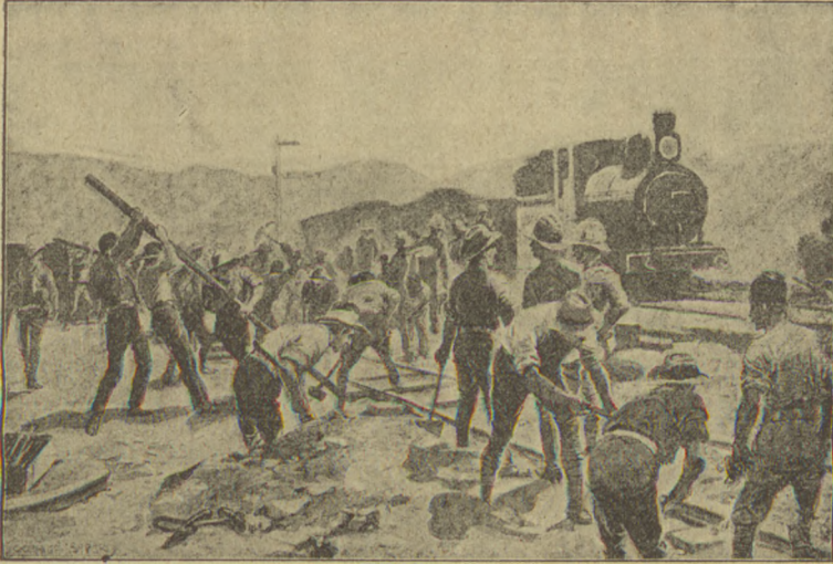
Zustandsetzen einer durch die Buren zerstörten Eisenbahnstrecke.
