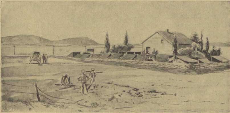
Von den Engländern verrammeltes Blockhaus zum Schutze der Bahnlilien. (Nach der Skizze eines englischen Offiziers).
