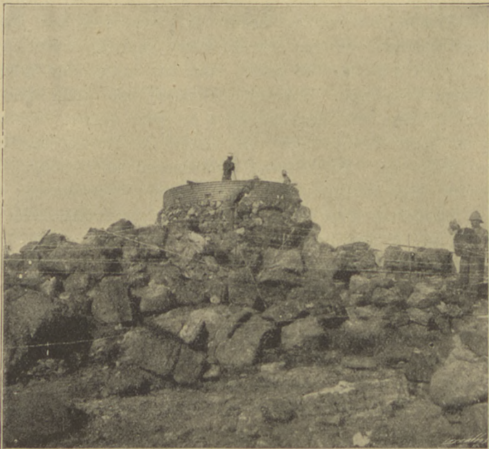
Bau eines Blockhauses auf felsigem Boden. Im Vordergrund Schutz-Stachelbrähre
