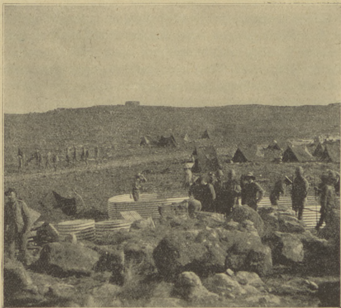
Lord Kitcheeners Blockhausystem: Errichtung eines Blockhauses aus Wellblech.
