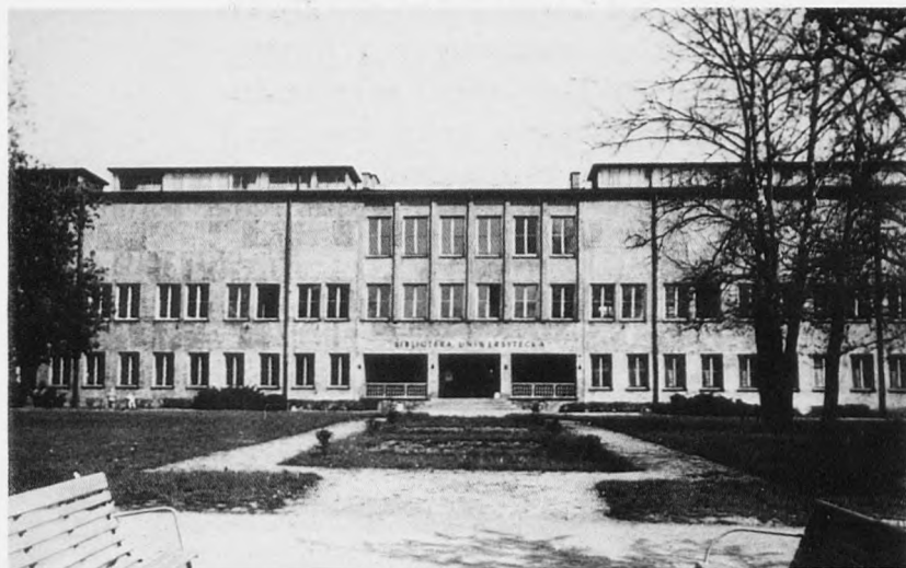
Stary budynek Biblioteki Uniwersyteckiej w Toruniu
