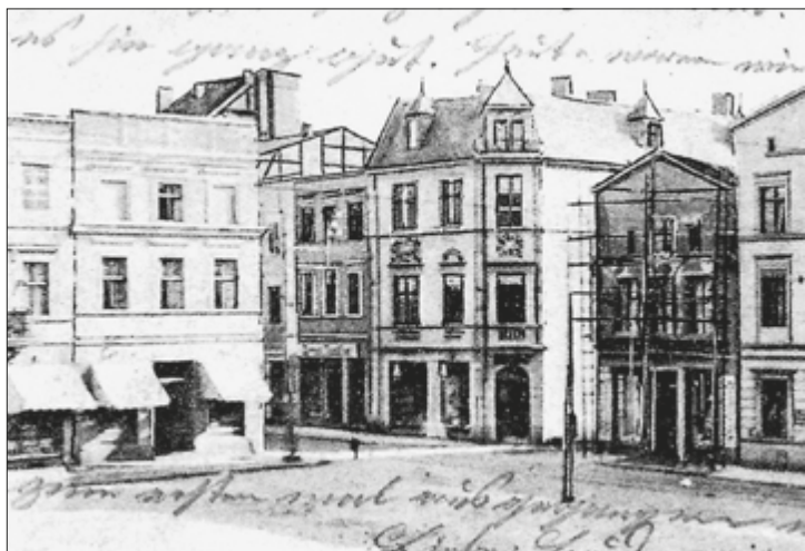
Il. 9. Fragment pocztówki z 1903 r. (wyd. Moritz Maschke, Grudziądz) z widoczną w tle zabudową ul. Długiej (fragmenty ścian szczytowych w konstrukcji szkieletowej)
