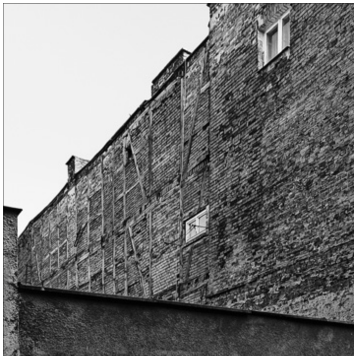
Il. 12. Grudziądz. Łącznik pomiędzy budynkami przy ul. Spichrzowej 24 i Pańskiej 14 postawiony w konstrukcji szkieletowej w 1857 r. Elewacja frontowa obecnie jest otynkowana
