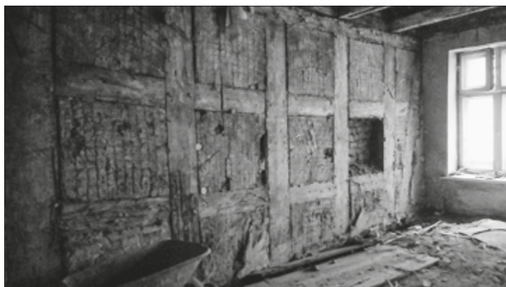
Il. 7. Grudziądz. Zachowana ściana boczna budynku przy ul. Długiej 16 postawiona w konstrukcji szkieletowej (stan: 28.02.2019, w trakcie prac remontowych)
