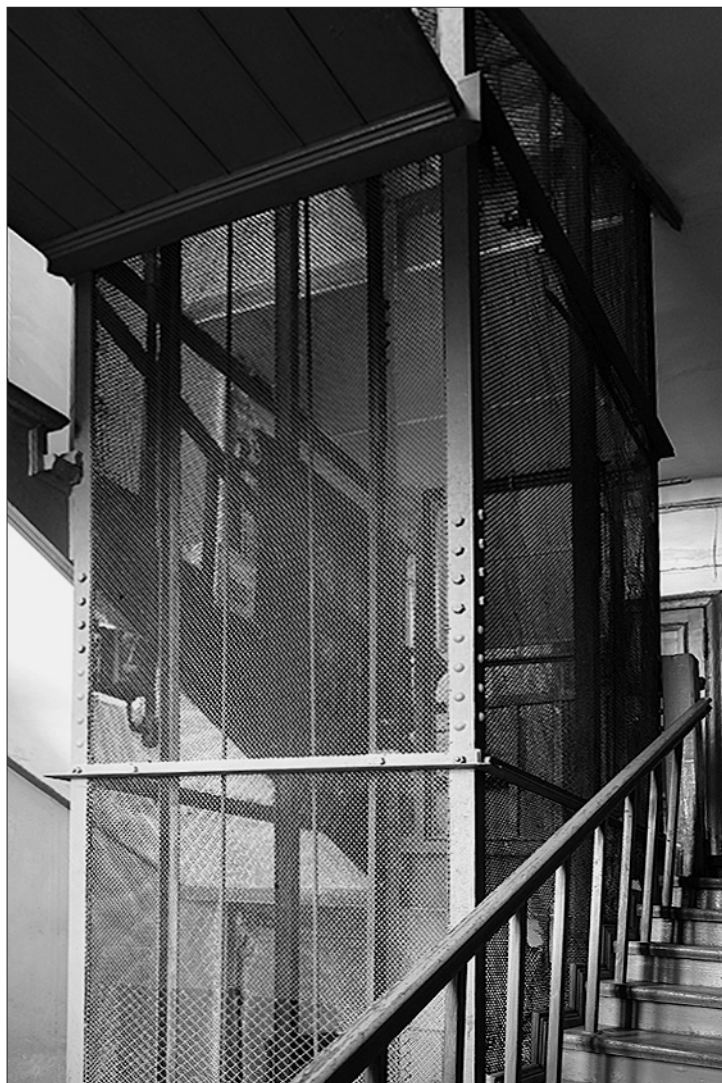
Il. 2. Grudziądz, dźwig osobowy w kamienicy przy ul. Legionów 31, szyb dźwigowy w duszy klatki schodowej. Fot. Katarzyna Pietrzak, 2022.
