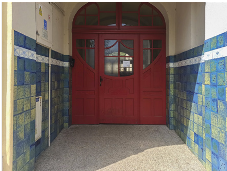
82 Il. 30. Grudziądz. Kamienica przy ul. Nadgórnej 57, 57 A, stan z 2022 r. po pracach remontowych, odkryte płytki ceramiczne. Fot. I. Fijałkowska.
