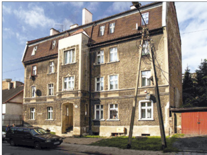
Il. 31. Grudziądz. Kamienica przy ul. Nadgórnej 31, stan z 2006 r. Źródło: Archiwum Biura Miejskiego Konserwatora Zabytków w Grudziądzu.
