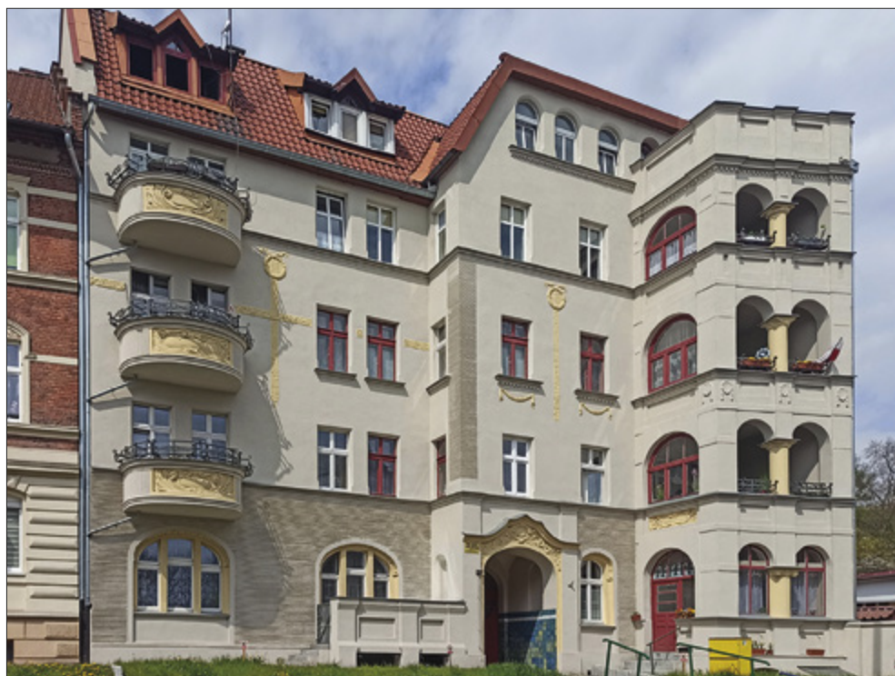
Il. 29. Grudziądz. Kamienica przy ul. Nadgórnej 57, 57 A, stan z 2022 r. po pracach remontowych odtwarzających kolorystykę elewacji. Fot. I. Fijałkowska
