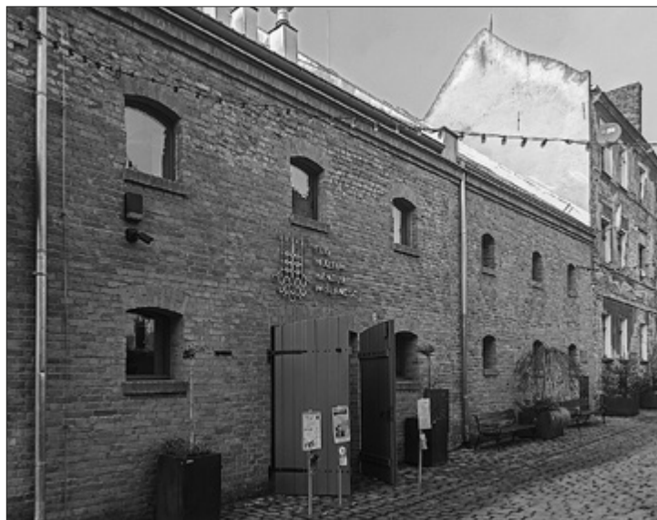
Il. 5. Elewacje Muzeum Handlu Wiślanego od ul. Spichrzowej po pracach konserwatorskich. Fot. I. Fijałkowska
