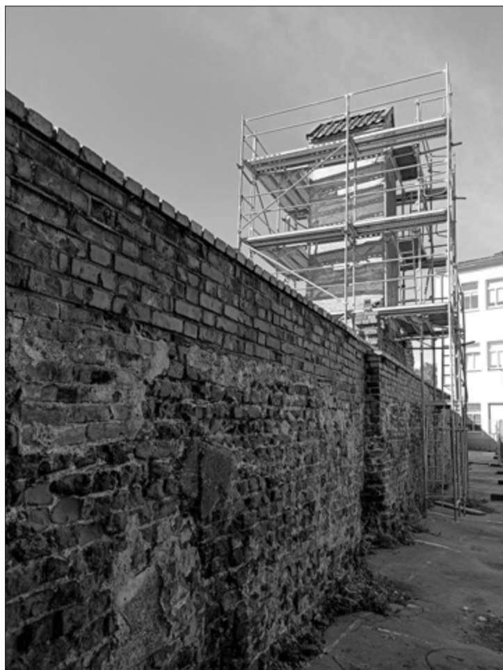
II. 2. Mury miejskie w trakcie prac konserwatorskich (stan na 07.09.2022). Fot. I. Fijałkowska
