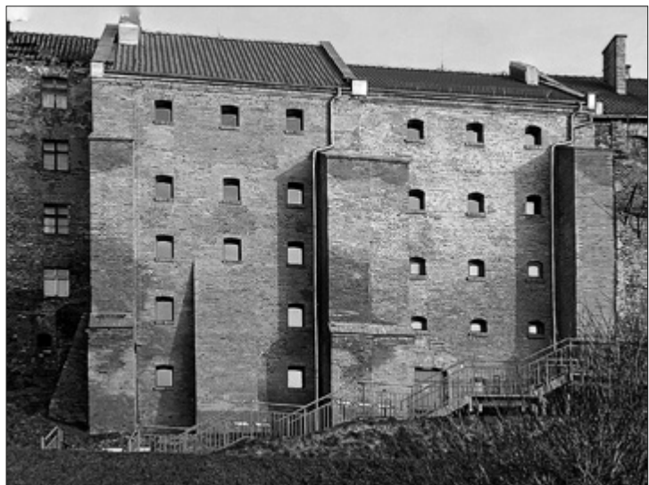
Il. 4. Elewacje Muzeum Handlu Wiślanego od strony Wisły po pracach konserwatorskich. Fot. I. Fijałkowska
