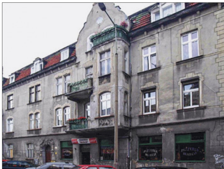
Il. 32. Grudziądz. Kamienica przy ul. Grobłowej 4, 4a, stan z 2006 r. Źródło: Archiwum Biura Miejskiego Konserwatora Zabytków w Grudziądzu.
