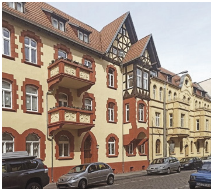
Il. 27. Grudziądz. Kamienice przy ul. Kościuszki 37 i 39. Stan z 2021 r. po pracach remontowych odtwarzających kolorystykę elewacji. Fot. I. Fijałkowska
