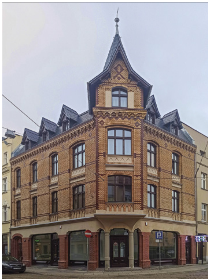
Il. 13. Grudziądz. Kamienica przy ul. Długiej 9 / Starorynkowej 10, stan z 2022 r. po pracach remontowo-konserwatorskich. Fot. I. Fijałkowska.
