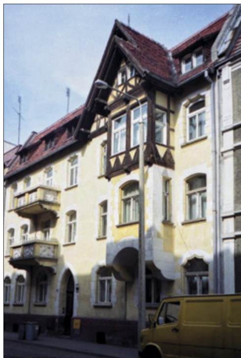
Il. 25–26. Grudziądz. Kamienice przy ul. Kościuszki 37 i 39, stan z 2002 r.
