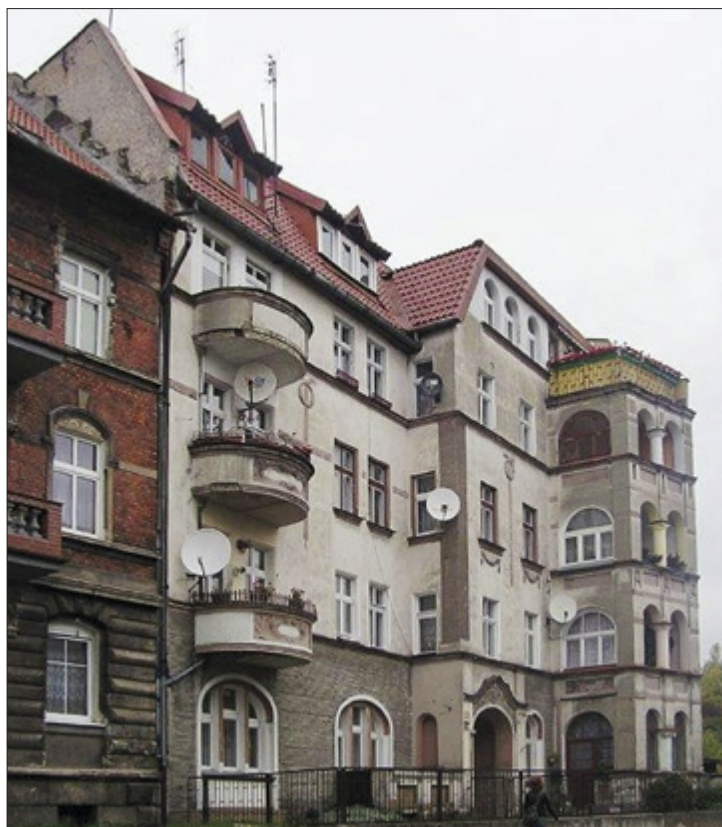
Il. 28. Grudziądz. Kamienica przy ul. Nadgórnej 57, 57A, stan z 2011 r. Źródło: Archiwum Biura Miejskiego Konserwatora Zabytków w Grudziądzu.
