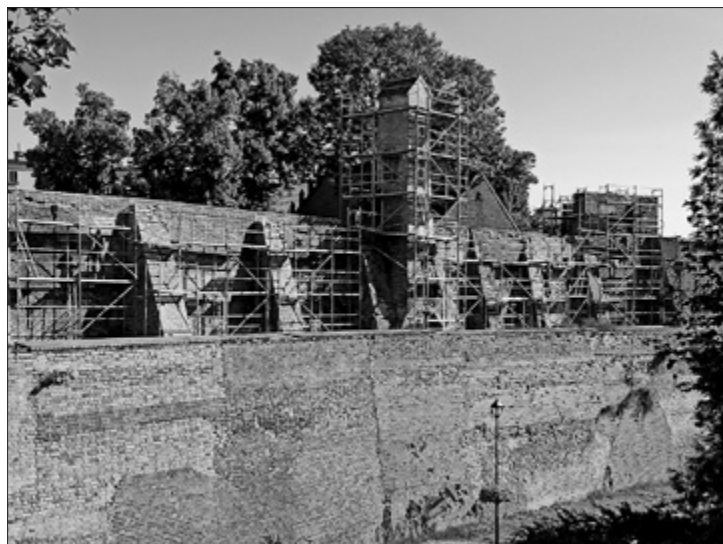
II. 1. Mury miejskie w trakcie prac konserwatorskich (stan na 07.09.2022). Fot. I. Fijałkowska
