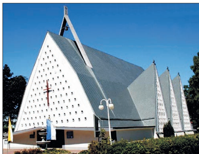
Rys. 4. Założenie jednorodne o konfiguracji dachowo-ściennej z korpusem namiotowym (Władysławowo koło Pucka)
