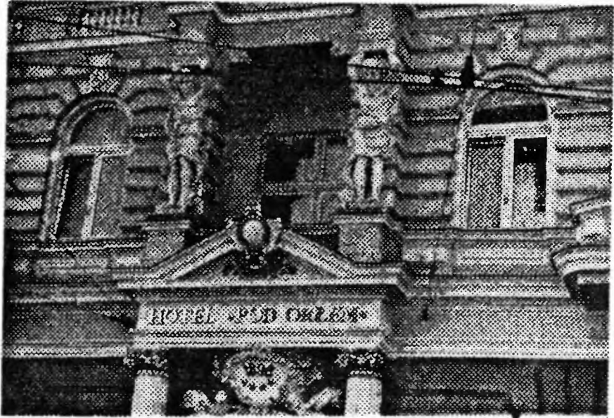
Zwieńczenie portalu i fragment wnęki na osi głównej budynku
