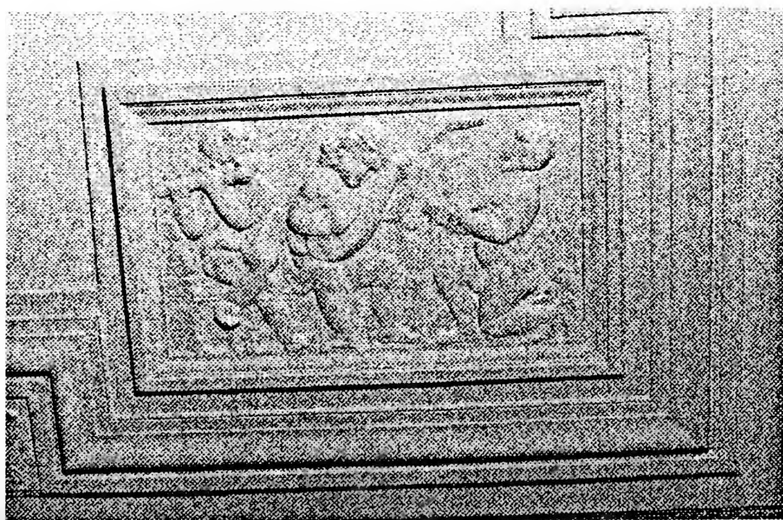
Fragment sztukaterii na suficie zapewne z pierwotnego wystroju pokoju na parterze
