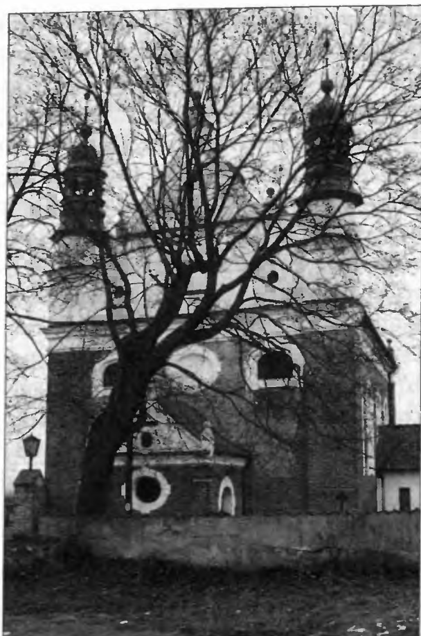
2. Fasada kościoła (stan obecny); fot. A. Jankowski.
