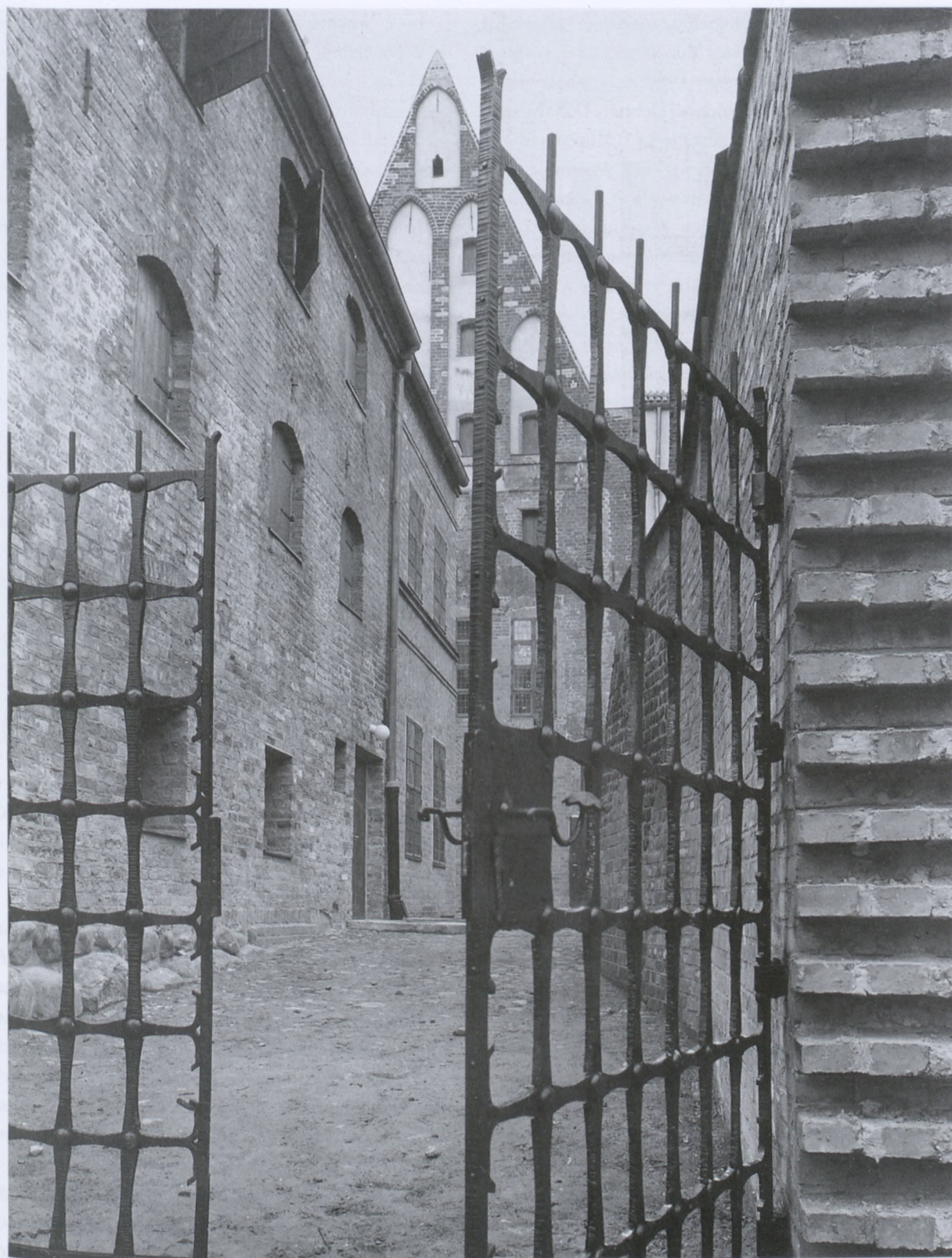
Widok od ulicy Rabskiej, od podwórza na elewację południową kamienicy nr 15 i na oficynę po przeprowadzeniu gruntownej konserwacji w 1972/73 roku. Fot. Czesław Kuchta, Jerzy Wardak
