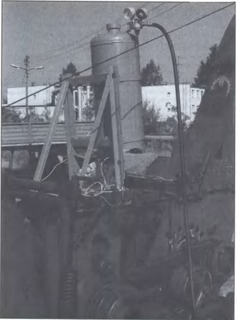
Rys.25. Widok ciśnieniowego urządzenia do konserwantów ciekłych (seria wdrożeniowa) Fig.25. The view of pressure - type metering device for liquid preservatives (pilot lot)
