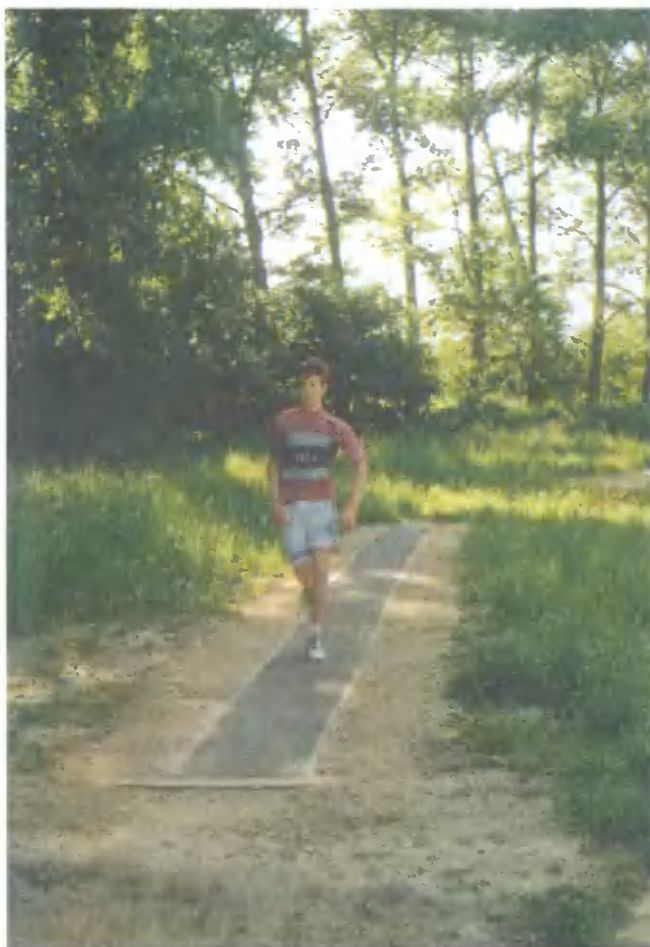
Fot.7. Rozbieg eksploatowanej 2 sezony skoczni w dal, wykonanej z kompozytowego tworzywa wytworzonego z aglomeratu PE-LD i rozdrobnionej gumy w Zakładzie Przetwórstwa Tworzyw Sztucznych ATR w Bydgoszczy. Koszt wykonania jest porównywalny z rozbiegiem asfaltowym przy lepszych własnościach użytkowych. Jest to przykład niekonwencjonalnego wykorzystania aglomeratu PE-LD
