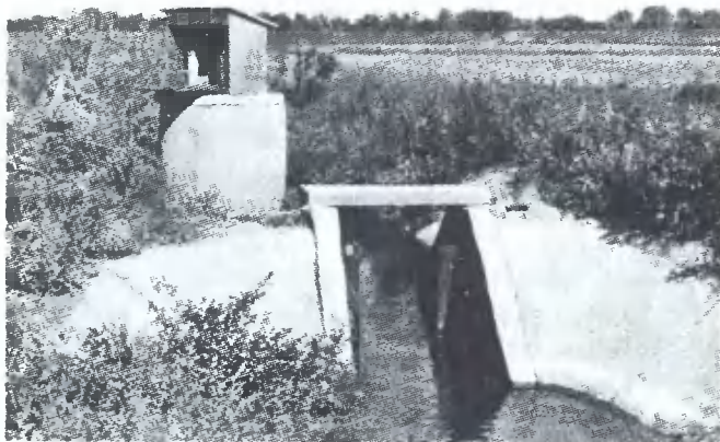
Rys.2. Urządzenie przelewowo - limnigraficzne
