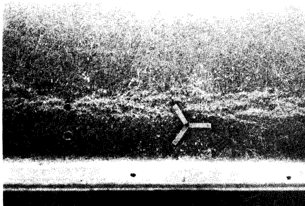
Rys.8. Wzdłużne rysy na górnej łupinie obudowy półkolistej
