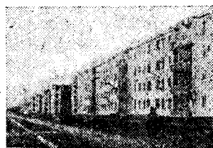
Fot.7. Budynek mieszkalny średnioniski 4 kondygnacyjny
