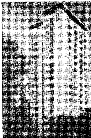
Fot.18. Budynek mieszkalny wysoki 18 kondygnacyjny
