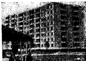
Fot.14. Budynek mieszkalny średniowysoki 7 kondygnacyjny
