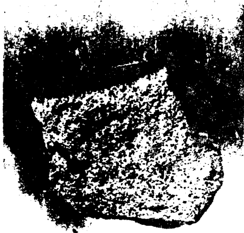
Rys.7. Średni stopień skorodowania boków kanału betonowego Ø 300 mm
