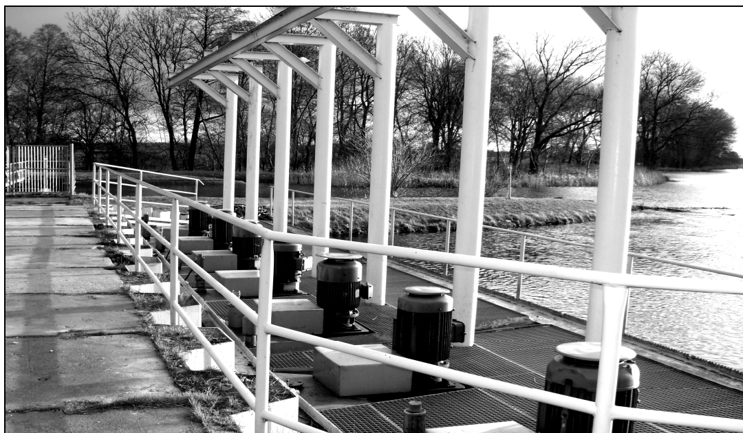
Fot 2. Nowy przekop i nowy jaz wraz z turbinami – oddany w 2008 roku. - widok z przodu (zdjęcia autorów)
