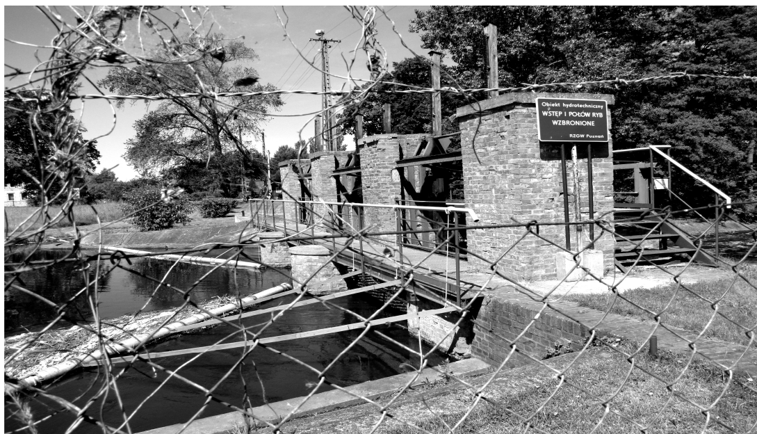
Fot 1. Jaz w Antoniewie wraz z elektrownią 2012 r.
