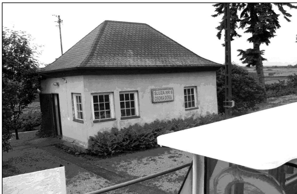
Ryc. 4. Śluza „Osowa Góra” – po poniesieniu widok ze statku na budynek śluzowy.
