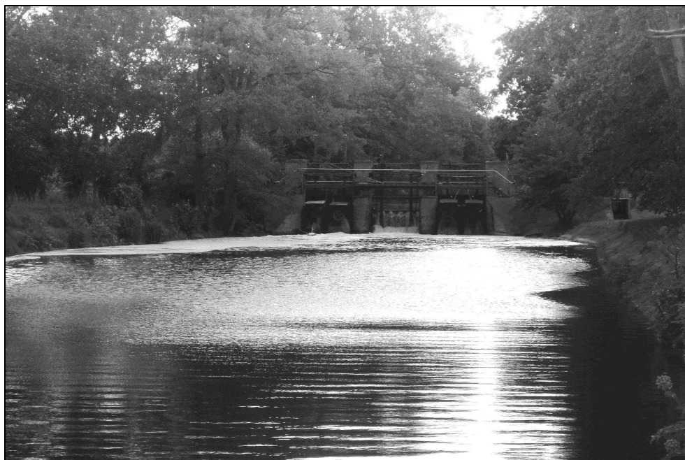
Ryc.9. Jaz z turbinami Małej Elektrowni Wodnej w Antoniewie – widok od strony zrzutu.
