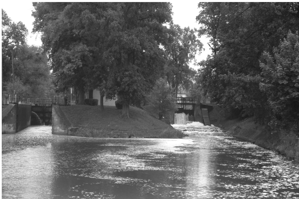
Ryc. 5.. Lisi Ogon : wejście do śluzy – po lewej , Mała Elektrownia Wodna - po prawej.
