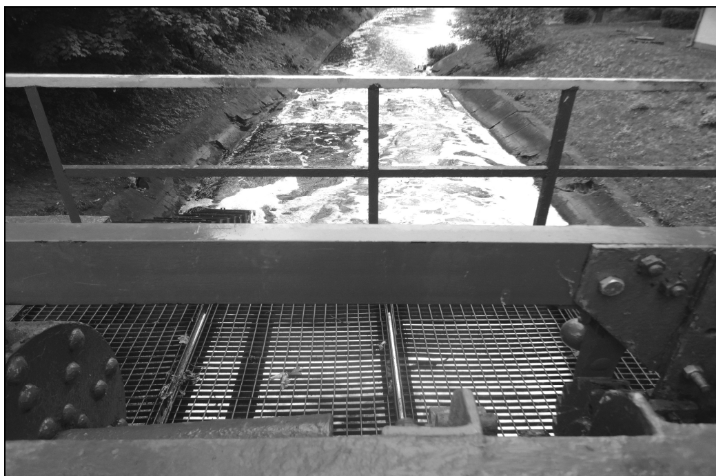
Ryc. 6. Lisi Ogon – Mała Elektrownia Wodna - widok od strony zrzutu wody.
