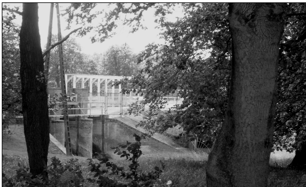
Ryc. 8. Stary jaz we Frydrychowie – z tyłu w głębi widok na nowoczesną Małą Elektrownię Wodną (firma „Mewat”)
