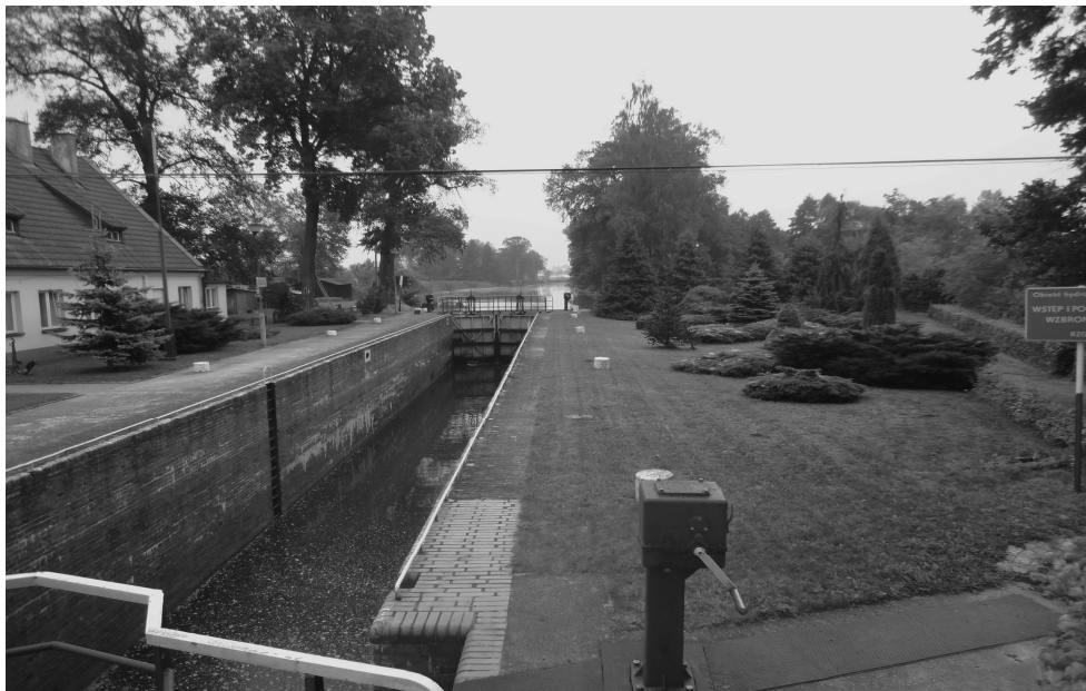
Ryc. 11. Śluza w Łabiszynie – widok w kierunku na Lubostroń (od ul Poznańskiej).
