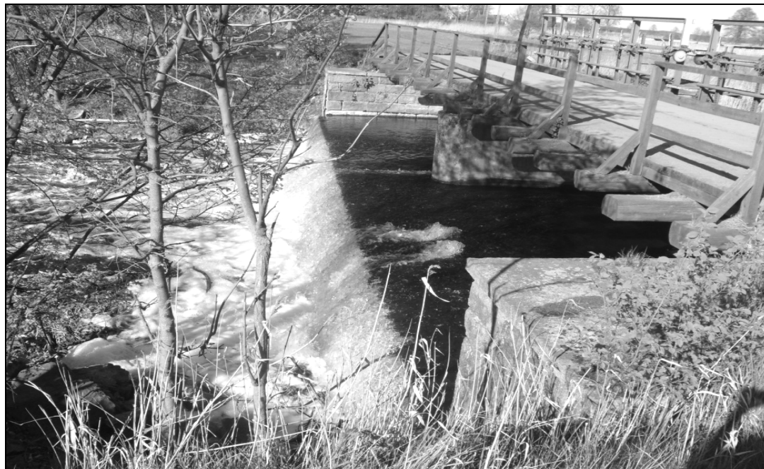
Ryc.11 Jeden z czterech mostów drewnianych na rozrzędem wodnym na Kanale Górnonoteckim w miejscowości Dębinek.
