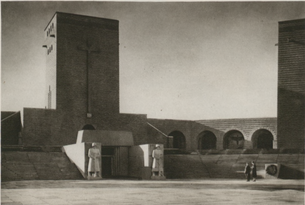
Abb. 10. Der Eingang der Hindenburggruft. Die Umgangsmauern sind jetzt noch etwas erhöht und überdeckt worden. Die Tieferlegung des Hofes zwang zu dieser Maßnahme
