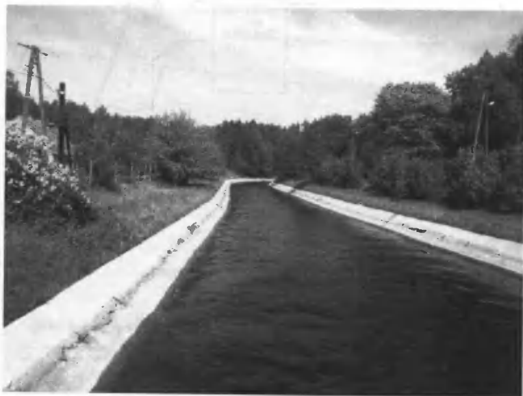
Widok kanału z mostu w kierunku zbiornika - 2012 r., fot. autor
