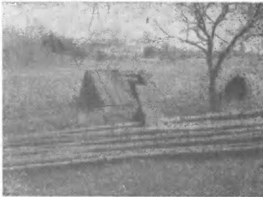
Fot.2. Studnia nr 8 obudowana nieszczelnymi deskami, wodę czerpano za pomocą kołowrotu przy użyciu wiadra stałego; wokół studni porzucane w nieładzie dręgi
