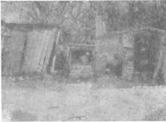
Fot.3. Studnia nr 7 o prymitywnej obudowie drewnianej z niezabezpieczonym włazem, bliskość budynków gospodarczych, nieuporządkowane otoczenie
