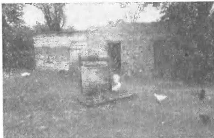
Fot.5. Studnia nr 2, bliskość budynków gospodarczych, brak obudowy zabezpieczającej przed zanieczyszczeniem otoczenia przez inwentarz
