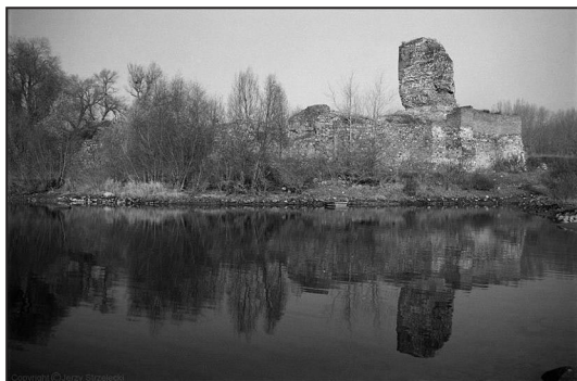
Ruiny zamku w Bobrownikach nad Wisłą
