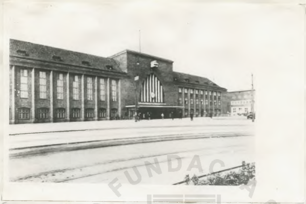
Królewiec. Dworzec Główny
