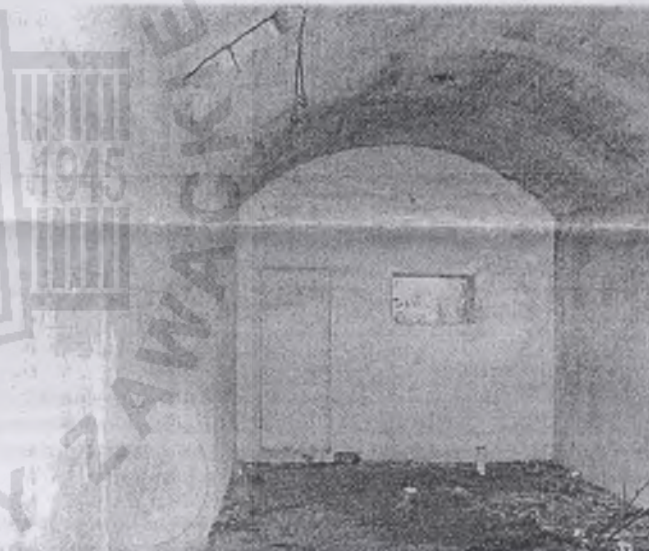
Wnętrze tego samego schronu - najprawdopodobniej magazynu. Widać w tle drzwi - tam było drugie wejście.
