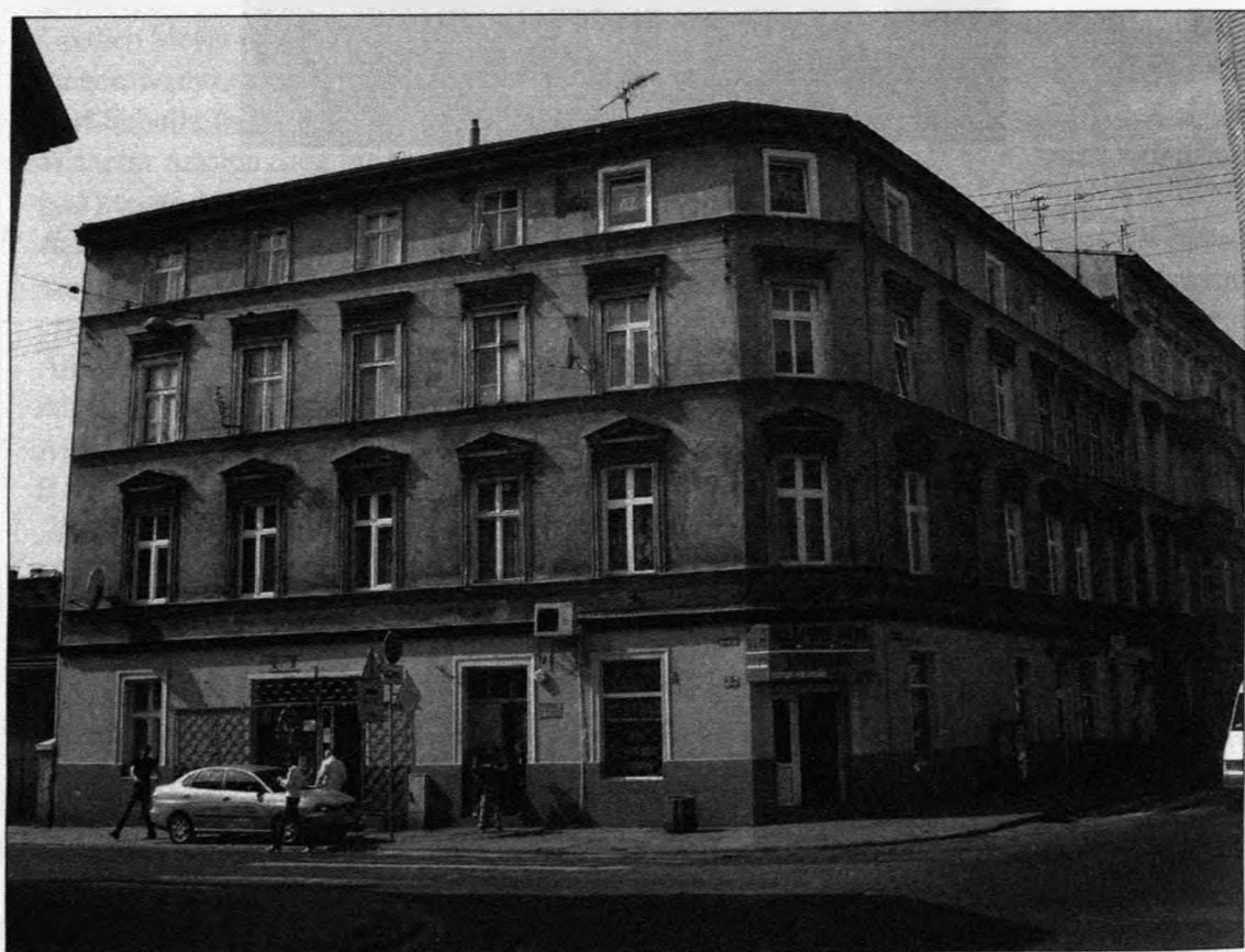
Kamienica przy ul. Pomorskiej 21, stan obecny. Fot. B. Derkowska-Kostkowska.
