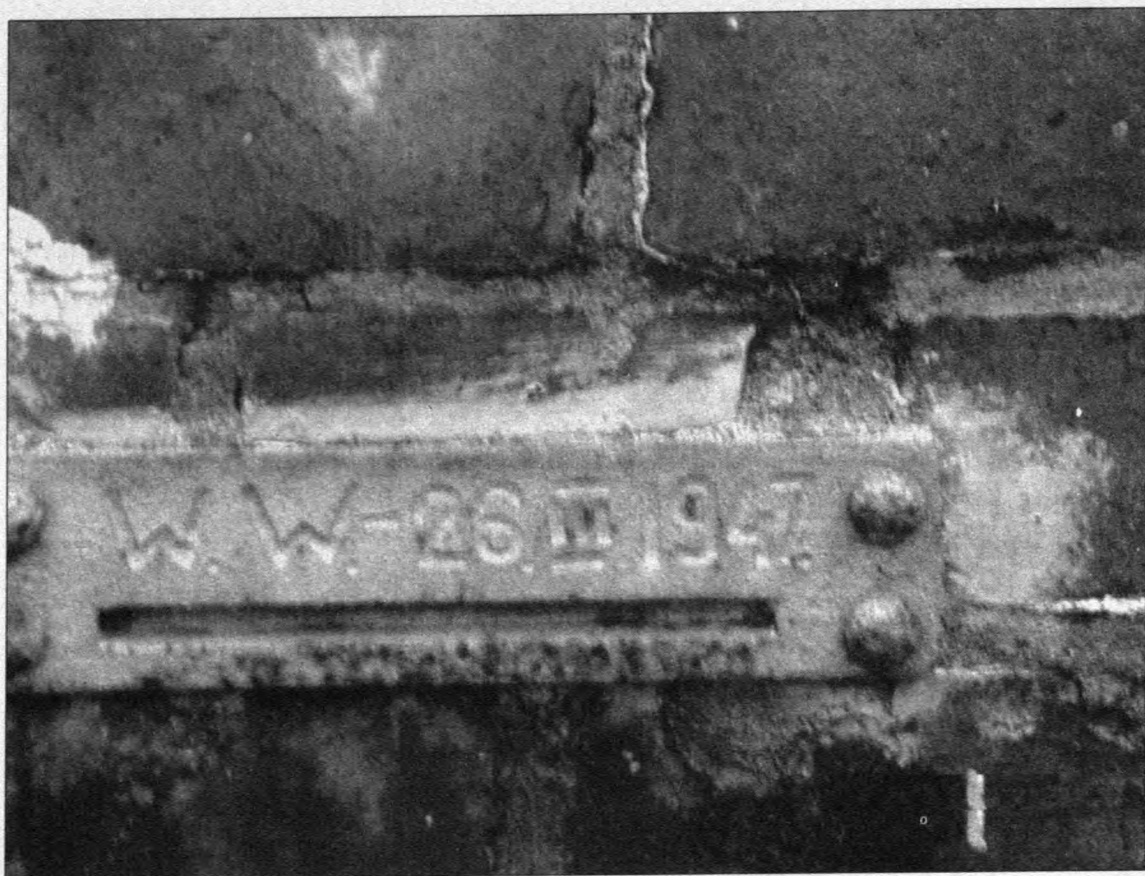
Znak wielkiej wody z 1947 r. znajdujący się na murze śluzy miejskiej.
