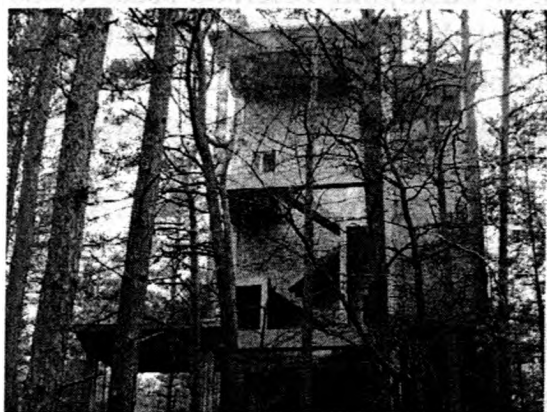
Budynek zateżania kwasów
