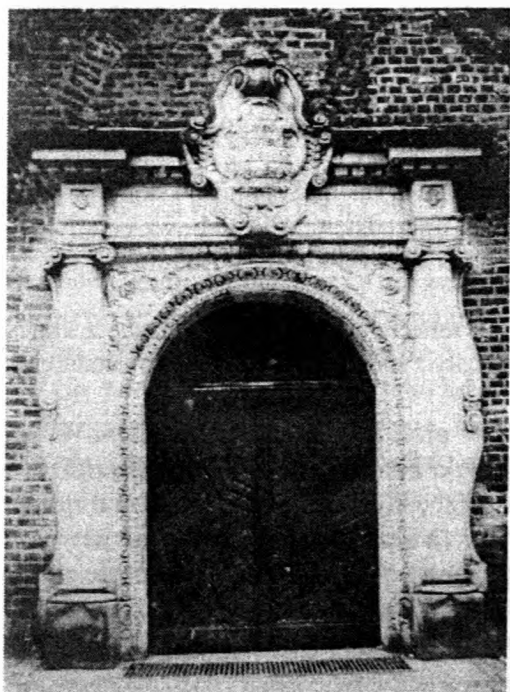
Kościół Klarysek, portal w ścianie zachodniej, ok. 1922-1925 (fot. ze zb. prywatnych E. Okonia)
