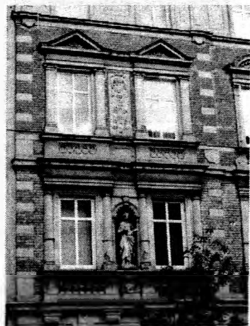
Il. 12. Bydgoszcz, ul. Gdańska 60, fragment elewacji, wzn. w poł. I. 90. XIX w., proj. C. Meyer (fot.)
