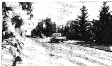
W 2009 r. przebudowana została m.in. ul. Widok
