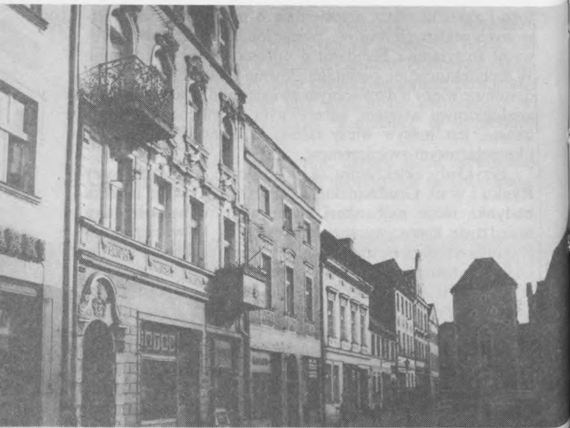
85. Eklektyczna zabudowa, ul. Grudziądzkiej
