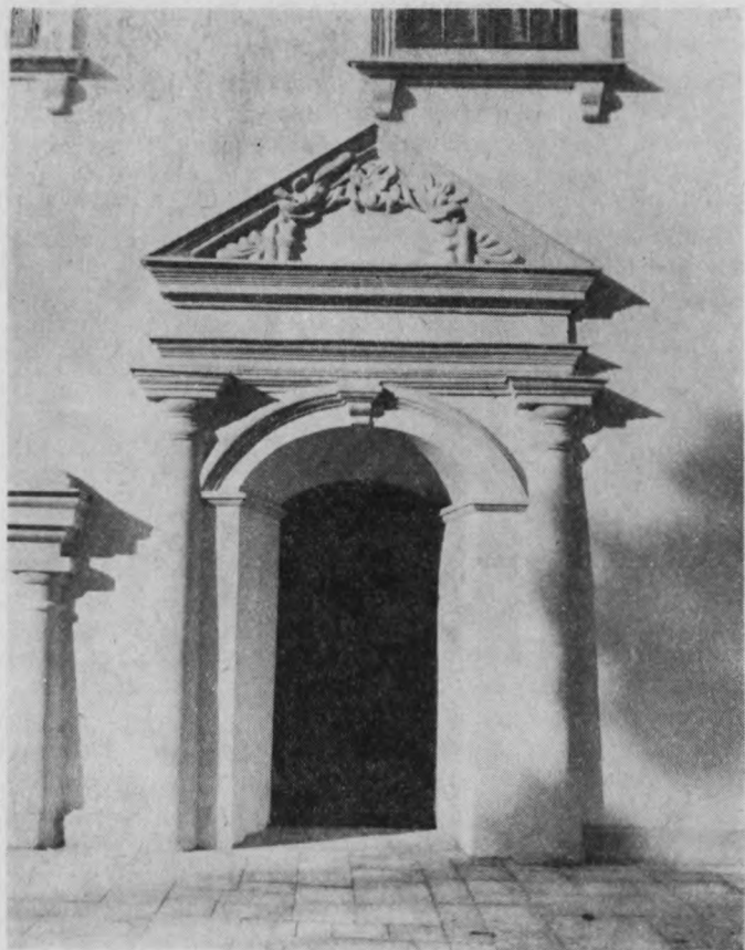
Portal w elewacji frontowej Ratusza od strony połudn.-wsch., XVI w.
