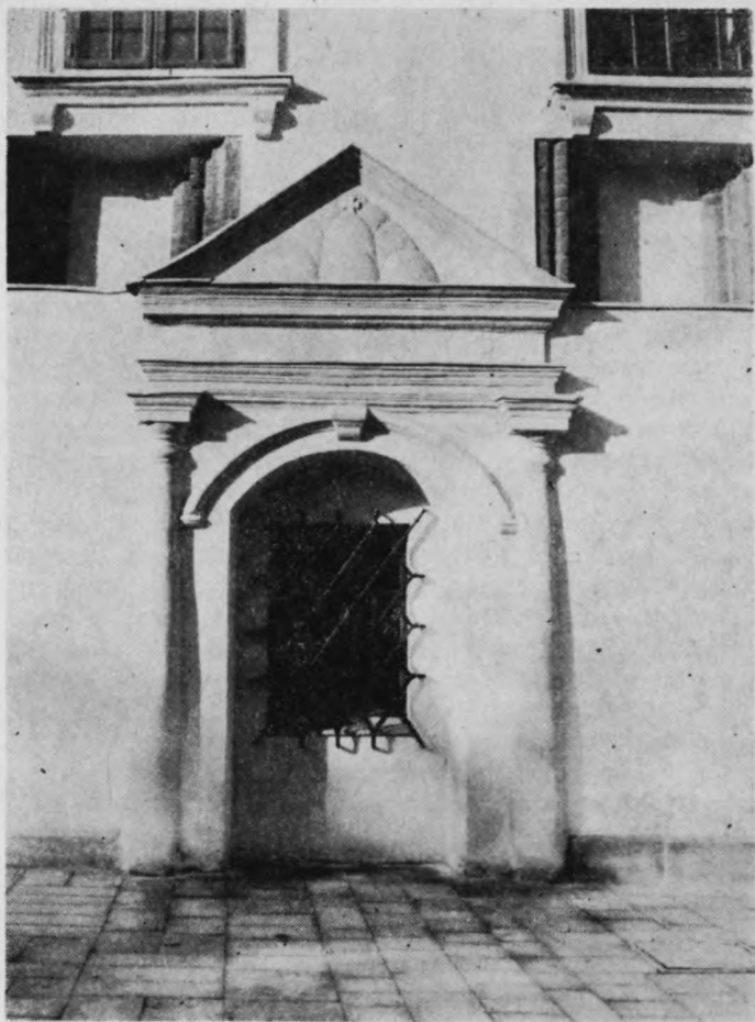
Fragment elewacji frontowej Ratusza z elementami gotyckimi odkrytymi w l. 1956–1959.
