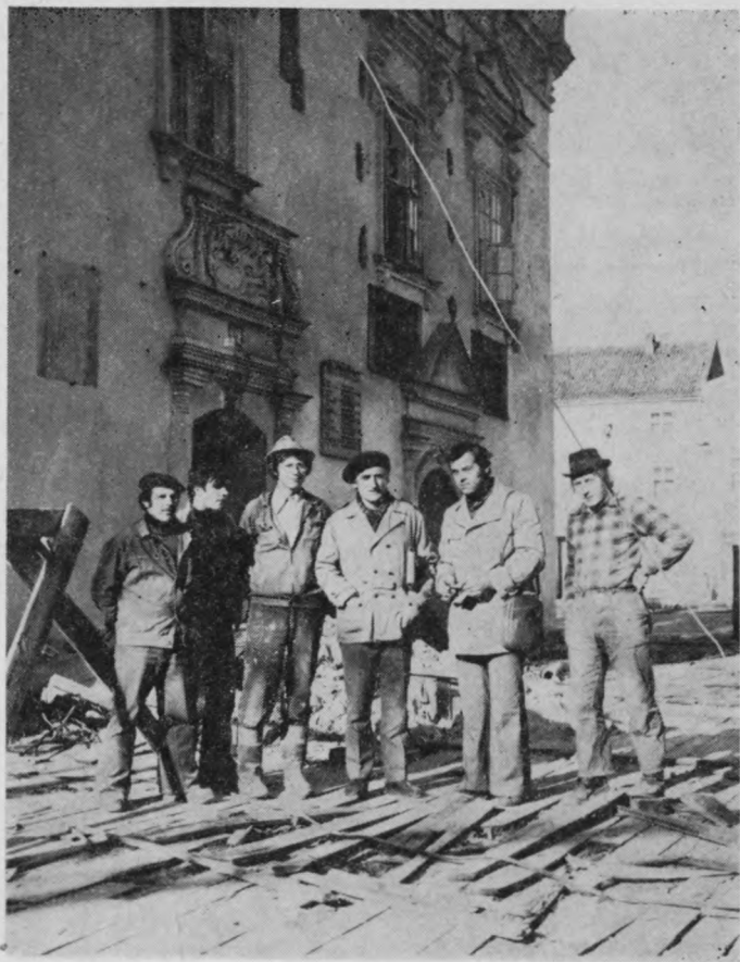
Ratusz z okresu prac remontowo-konserwatorskich, 1979 r.
